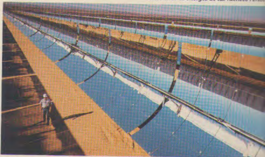
Primeros pasos hacia la era solar. La empresa californiana Luz vende a la red de suministro nacional la electricidad que generan sus colectores cilindro-parabólicos: 275 MW, de momento.
