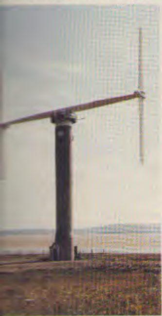
agosto de 1990 fue inaugurado en Gales el mayor aerogenerador europeo de eje vertical. Con una altura de 43 metros y un diámetro del rotor de 35 metros, tiene una potencia de 500 kW, suficiente para cubrir la demanda eléctrica de 50 viviendas.
