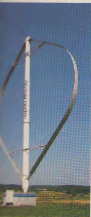
El eje vertical—como éste, de tipo Darrieus—no necesitan orientarse.
